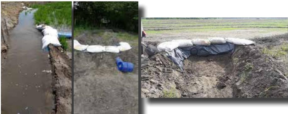
Fig. 8 Estanques de depósito de sedimentos
