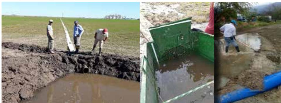
la manguera PBD logrando un orificio de 2.5 pulgadas de diámetro. Por este orificio podrá ingresar el agua al lote de manera controlada debido a la compuerta BG con paso regulado gracias a su válvula de cortina.
