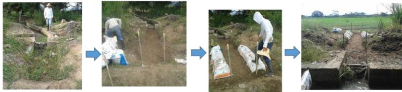
Adecuación del canal en tierra para asegurar flujo laminar
